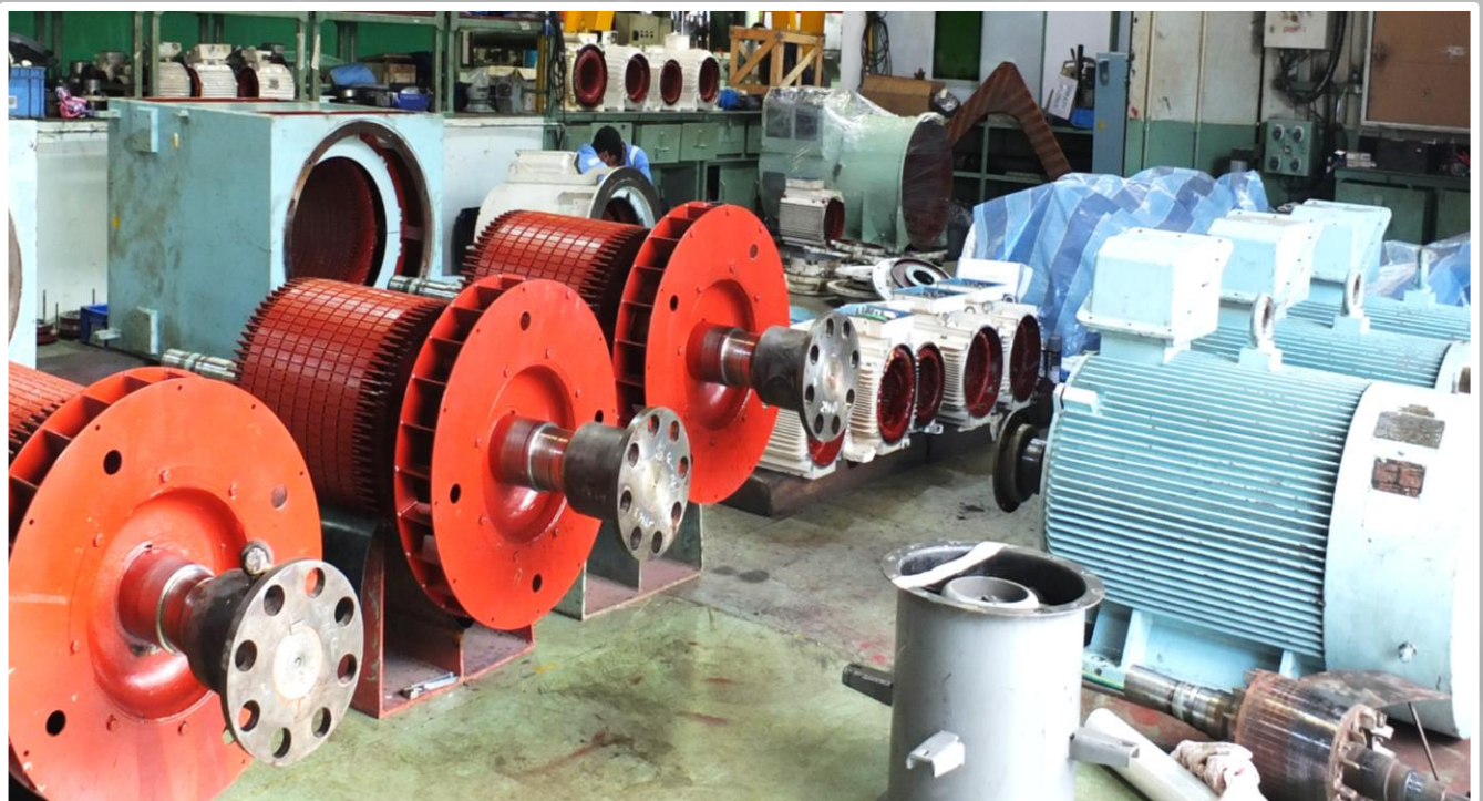
電動モーター開放点検
