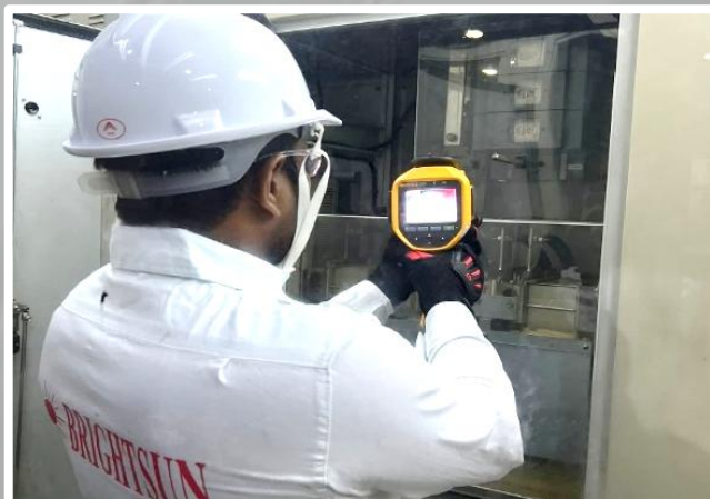
赤外線サーモグラフィック検査
