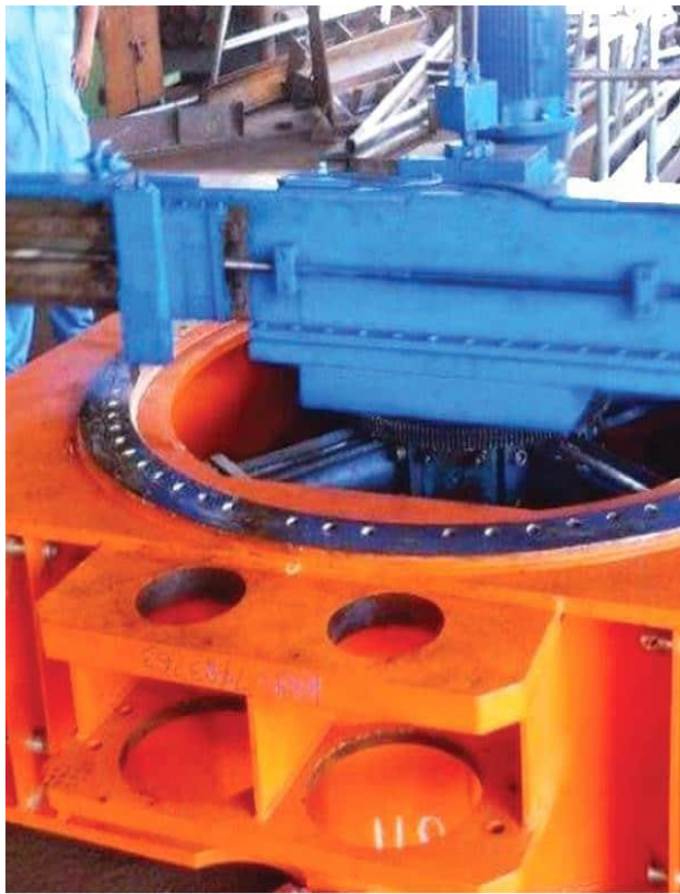
현장 크레인 받침대 플랜지 가공
