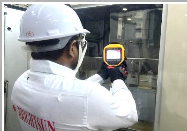
赤外線サーモグラフィック検査
