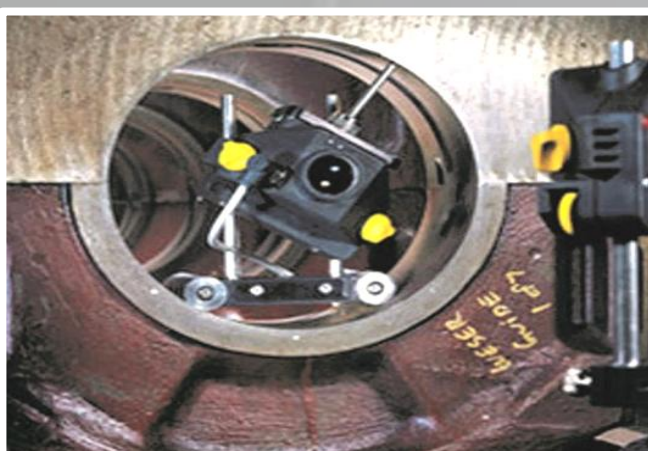
レーザーアライメント検査
