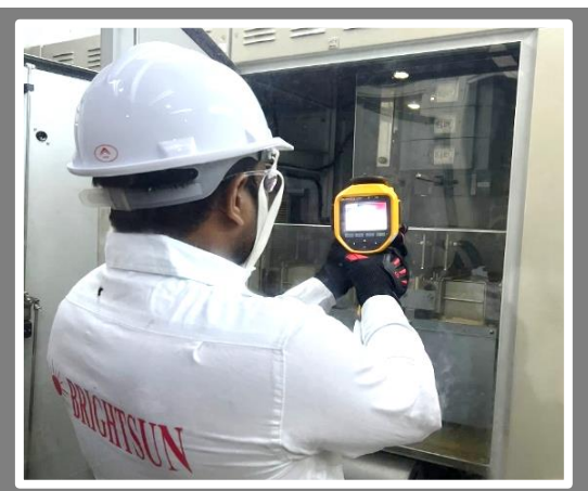
赤外線サーモグラフィック検査
